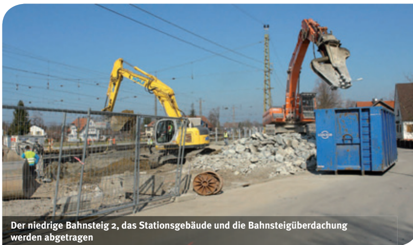
Die Bauarbeiten an der ÖBB-Haltestelle Lauterach gehen zügig voran
