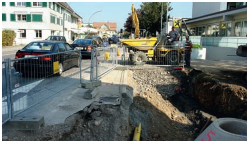
Die Bauarbeiten beim Montfortplatz schreiten zügig voran
