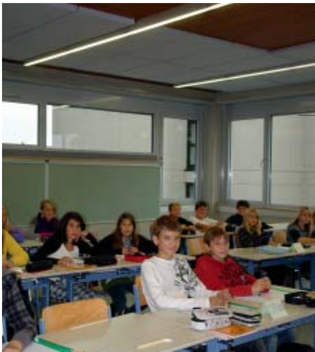
Die Absorberplatten vermindern die Geräuschkulisse im Klassenraum enorm
