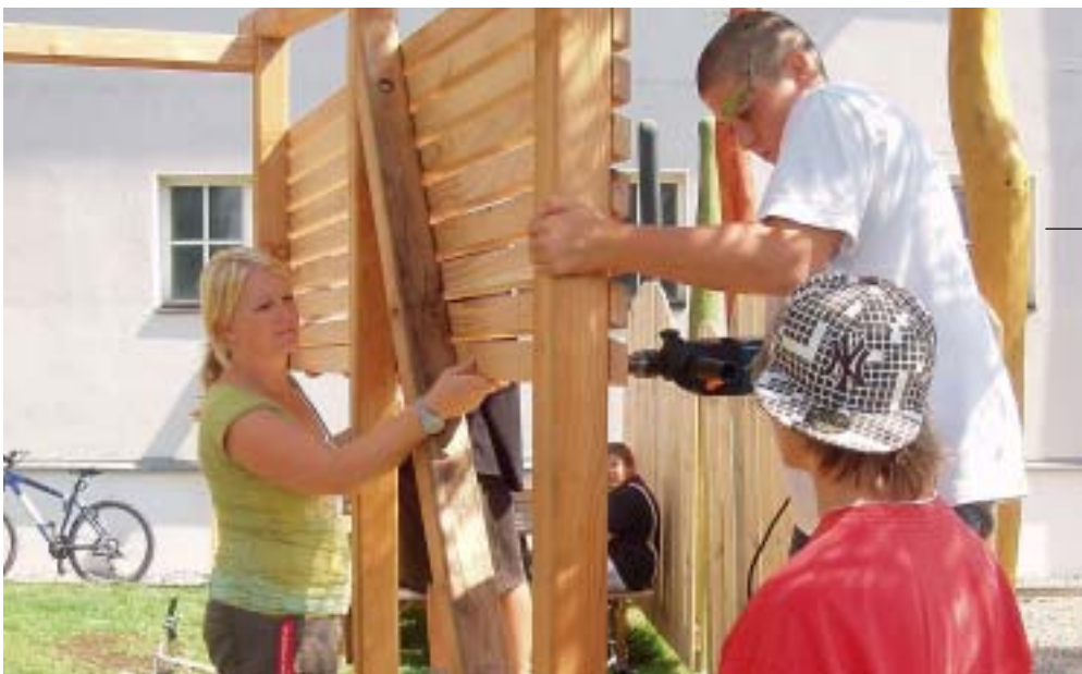
Viel Einsatz war für die Überdachung notwendig
