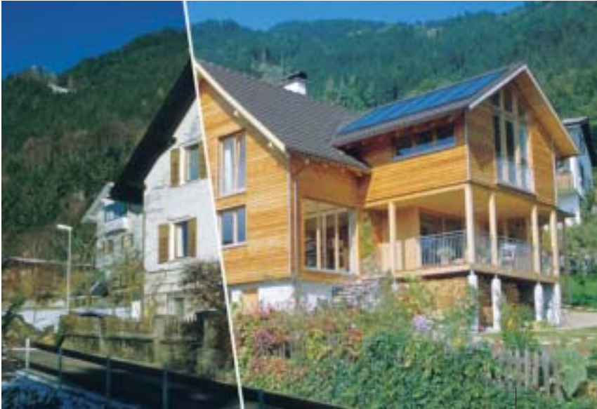
Das Land Vorarlberg fördert die Sanierungsberatung mit bis zu € 1.200
