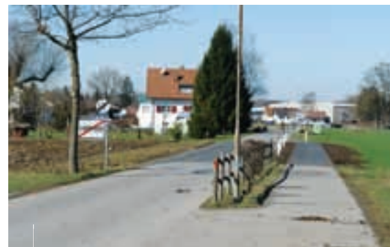
An der Grenze zu Hard konnte wieder ein Stück Radweg errichtet werden
