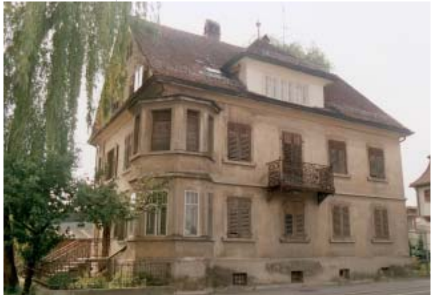
Das Haus des Bernhard Neyer, später Schachtel Marie-Haus, vor Verlegung des Eingangs
