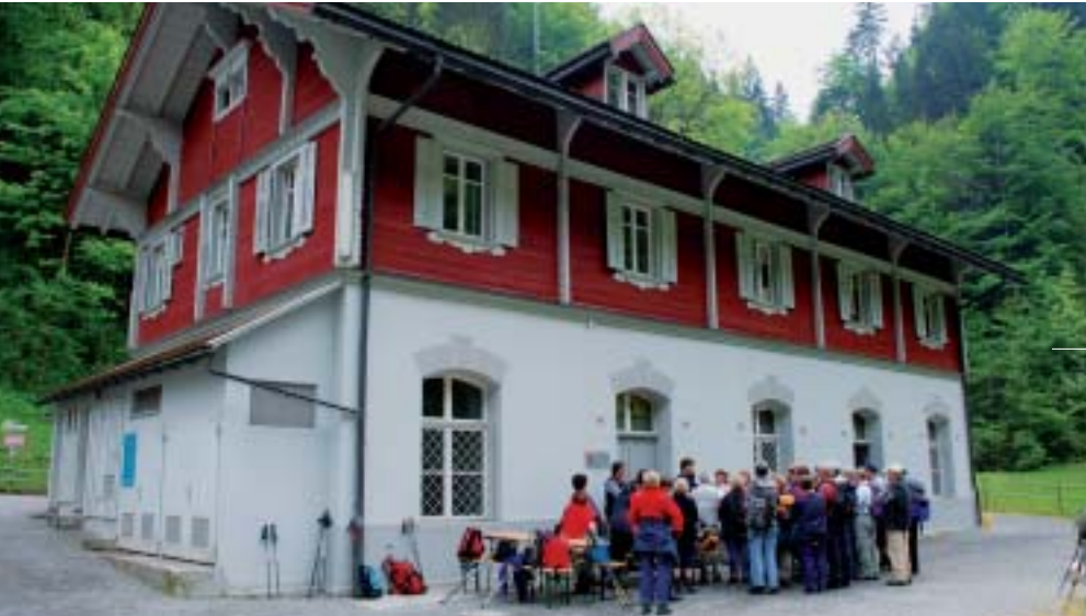
Besichtigung des Kraftwerks Ebensand am Staufensee
