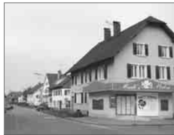
In diesem Bereich der Lerchenauerstraße wird die Ortskanalisation erneuert
