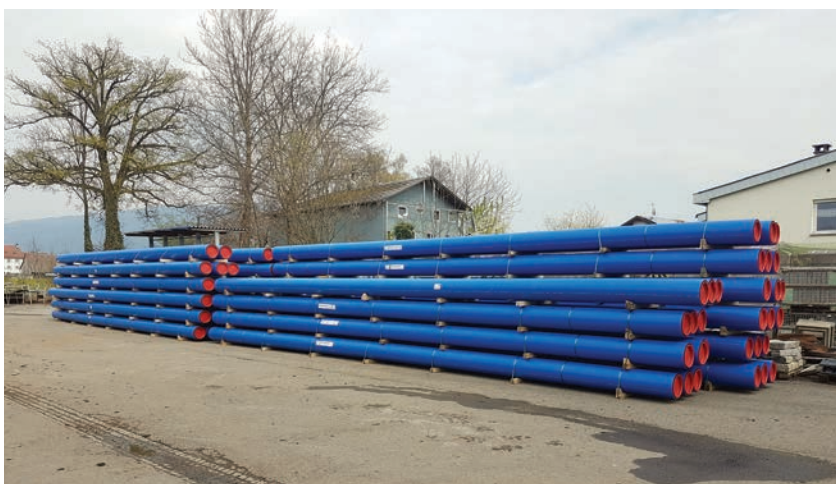
Die neuen Wasserrohre für die Notverbundleitung zur Marktgemeinde Hard
