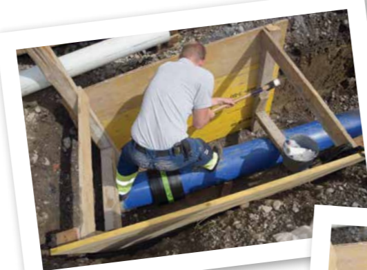
Christian Rummer fügt das letzte Anschlussrohr in die Notverbundleitung
