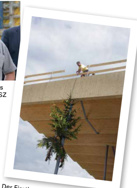
Der Firstbaum wurde auf das Dach des ASZ gesetzt
