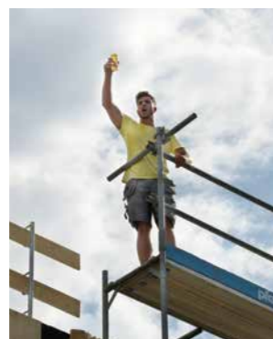
Stellvertretend für alle beim Bau beteiligten Handwerker wurde auf die Firstfeier angestoßen
