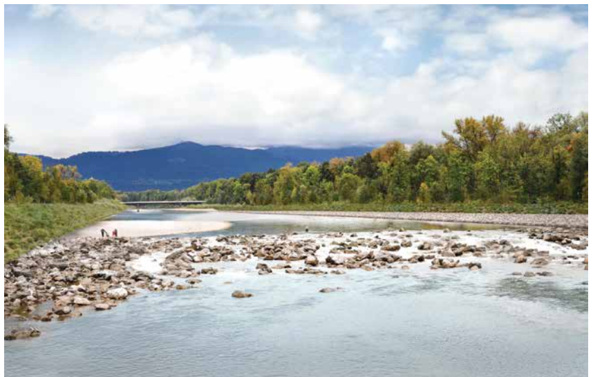
Zustand nach Baufertigstellung und Initialbepflanzung
