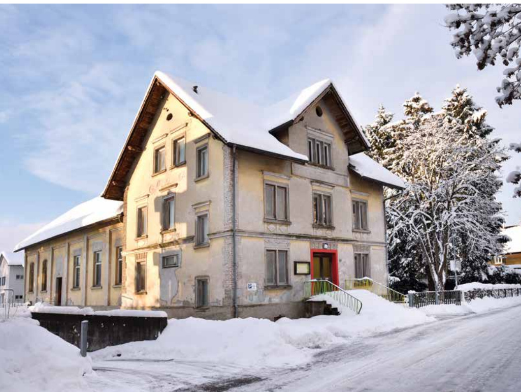
Das Vereinshaus wird grundsanziert
