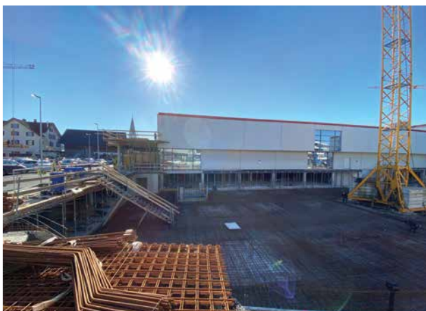
Die Bauarbeiten schreiten zügig voran
