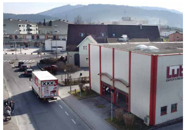
Der Kreuzungsbereich Karl-Höll-Straße zur Bundesstraße wird um eine zusätzliche Links- bzw. Rechtsabbiegespur erweitert
