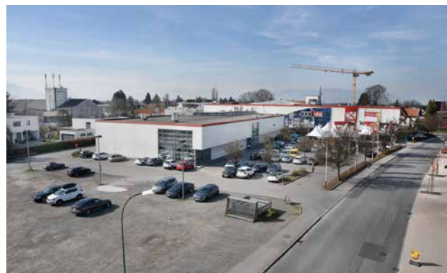
Der gesamte Bereich des XXXLutz wurde umgebaut
