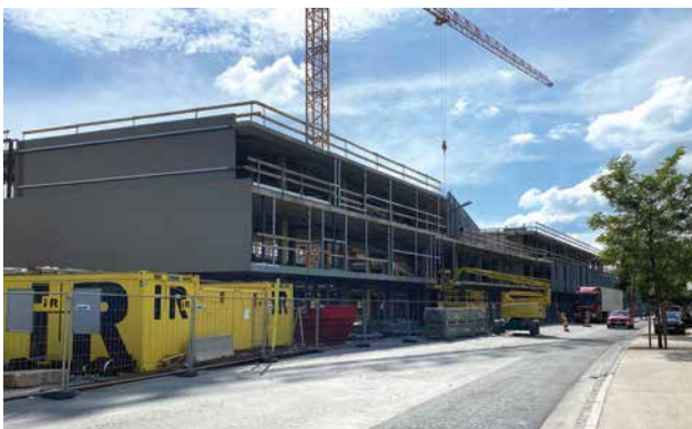
Während der Umbauarbeiten
