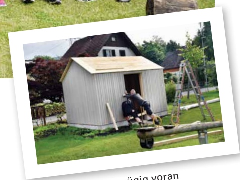
Der Aufbau ging zügig voran
