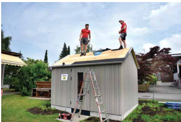
Die Dachdecker machten das Haus regensicher
