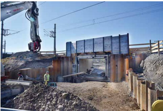
Neue Radunterführung Kaltenbrunnen
