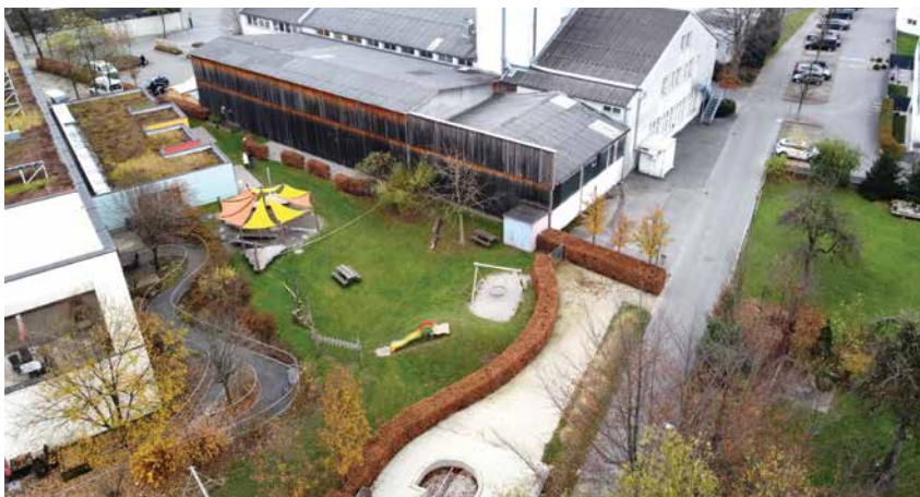
Der Anbau der Alten Säge wird entfernt und schafft Platz für den Neubau Gebäude 3b
