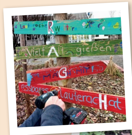
Der Wegweiser wurde repariert.
